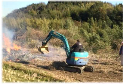
⇒ 根を重機で掘り出す
